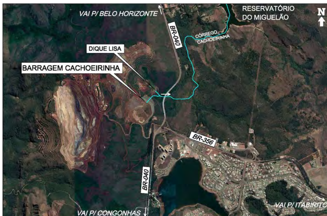
Figura 1.1 – Vista da Barragem de Rejeitos Cachoeirinha
