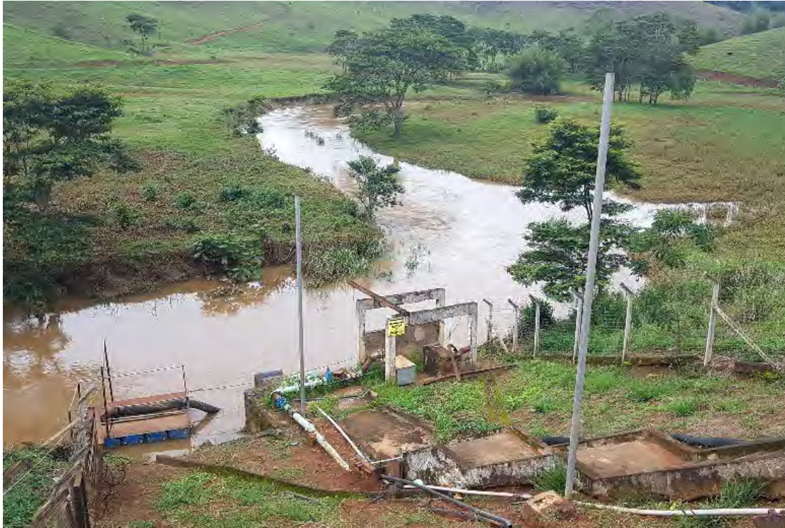
Figura 5: Ponto de captação da sede urbana de Matipó, realizada diretamente no rio Matipó.
