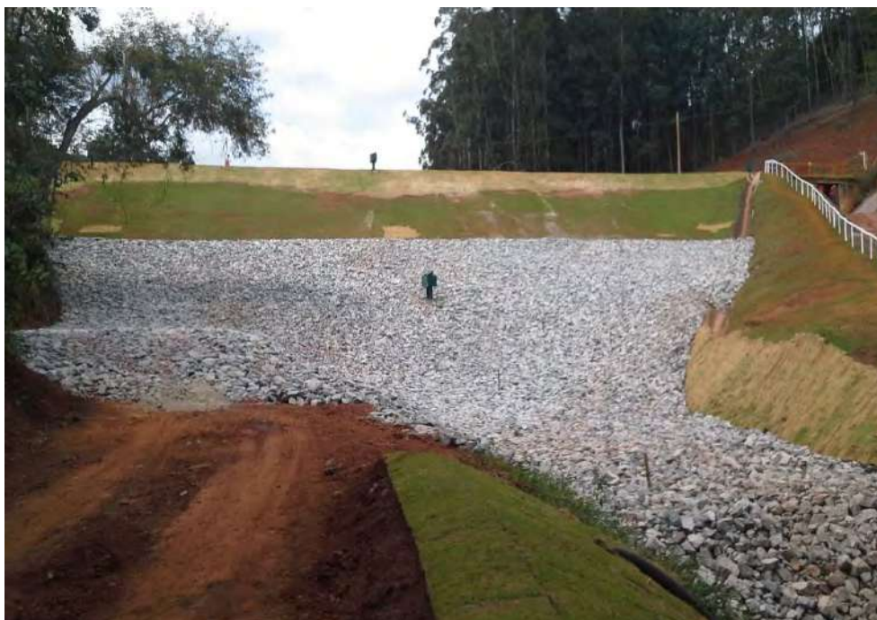
Figura 4: Vista do talude de jusante da barragem EBII.
