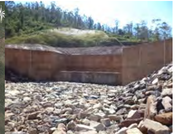
EMBOQUE DO EXTRAVASOR DE EMERGENCIA
