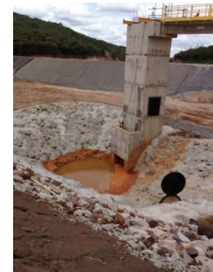
TORRE DO EXTRAVASOR OPERACIONAL
