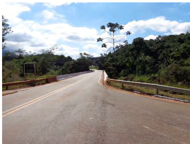
Figura 4.16 – Ponte sobre o rio Piracicaba, MG-129, limite da ZAS e ZSS, na entrada para o distrito de Santa Rita Durão (Fonte: AMPLO, 2016).
