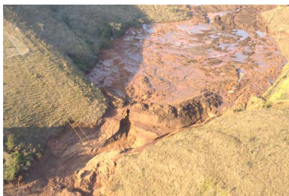
Rompimento de barragem – Mineração Herculano 2014
