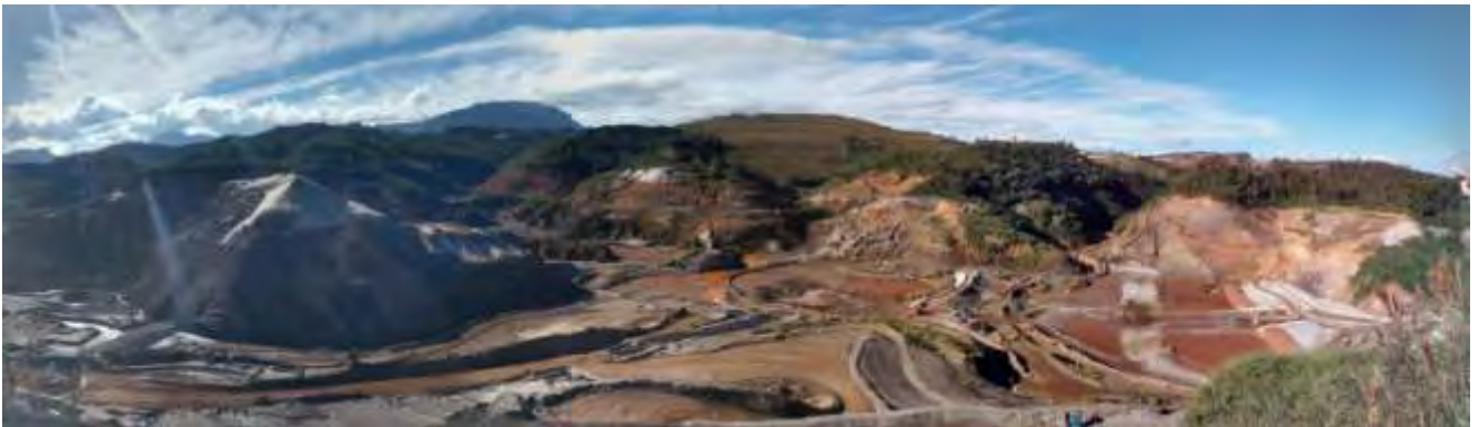
Eixo 1 – Obras dos sistemas de contenção de rejeitos remanescentes de Fundão
