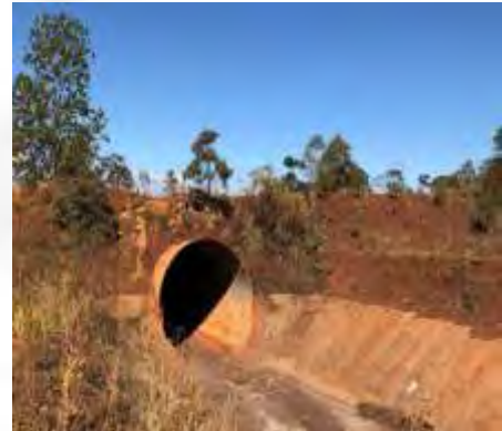
Foto 8 – Vista de um bueiro localizada em um trecho de canalização do córrego João Manoel.
