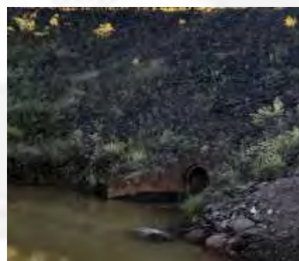
Foto 10 – Vista frontal de dois bueiros na bacia 18 que desagua no dique de Macacos ou dique B11.
