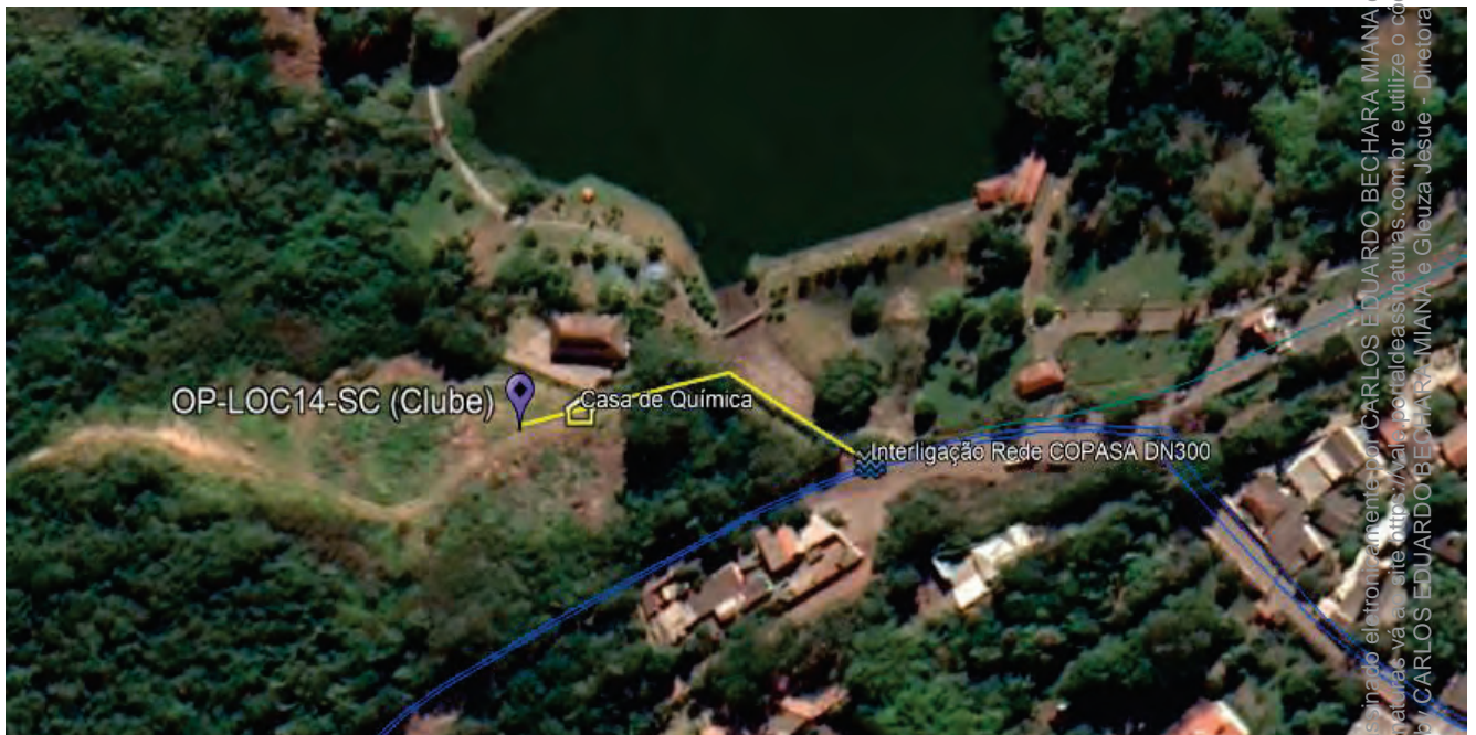
Figura 6 - Interligação poço tubular Clube Scharle
