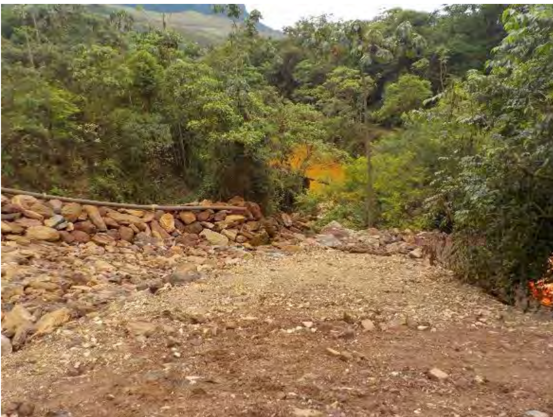
Figura 5: Vista do extravasor do dique B2 (Fonte: G103093-G-1RT001_R-01).
