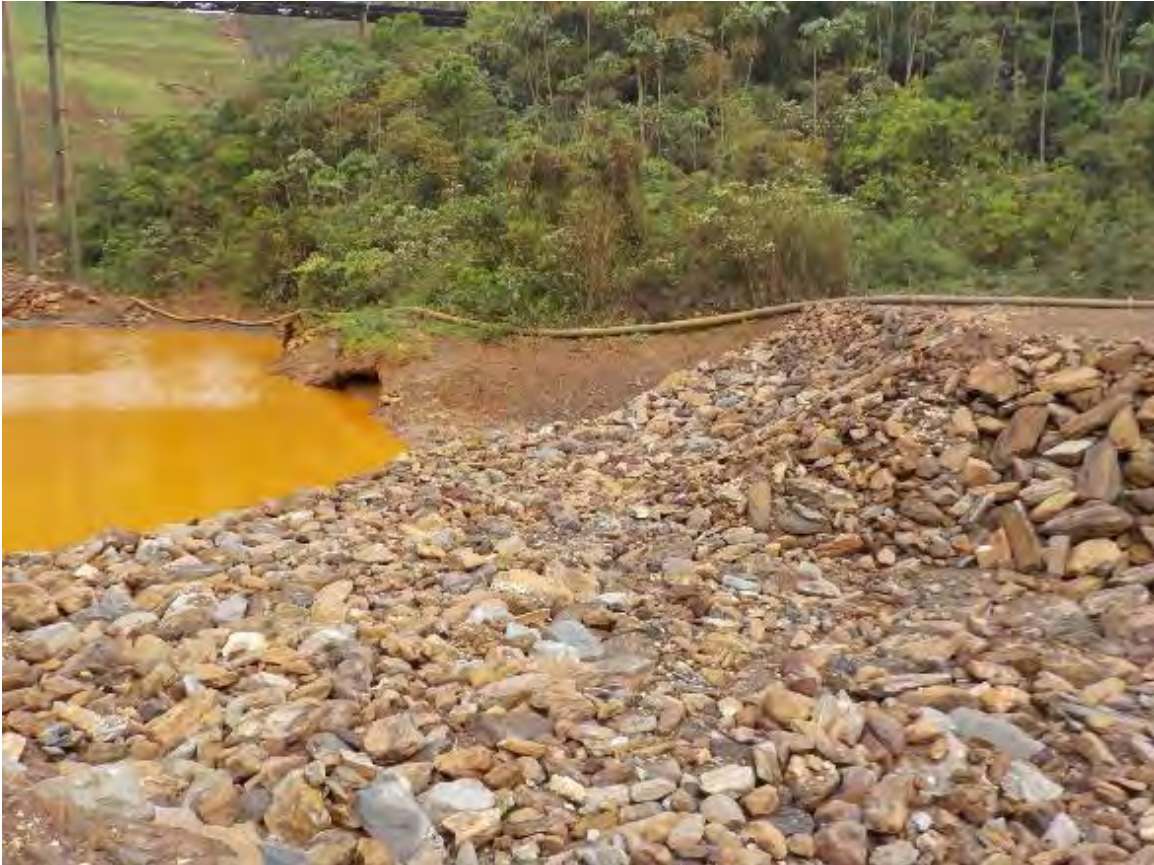
Figura 4: Vista a montante do maciço do dique B2 (Fonte: G103093-G-1RT001_R-01).
