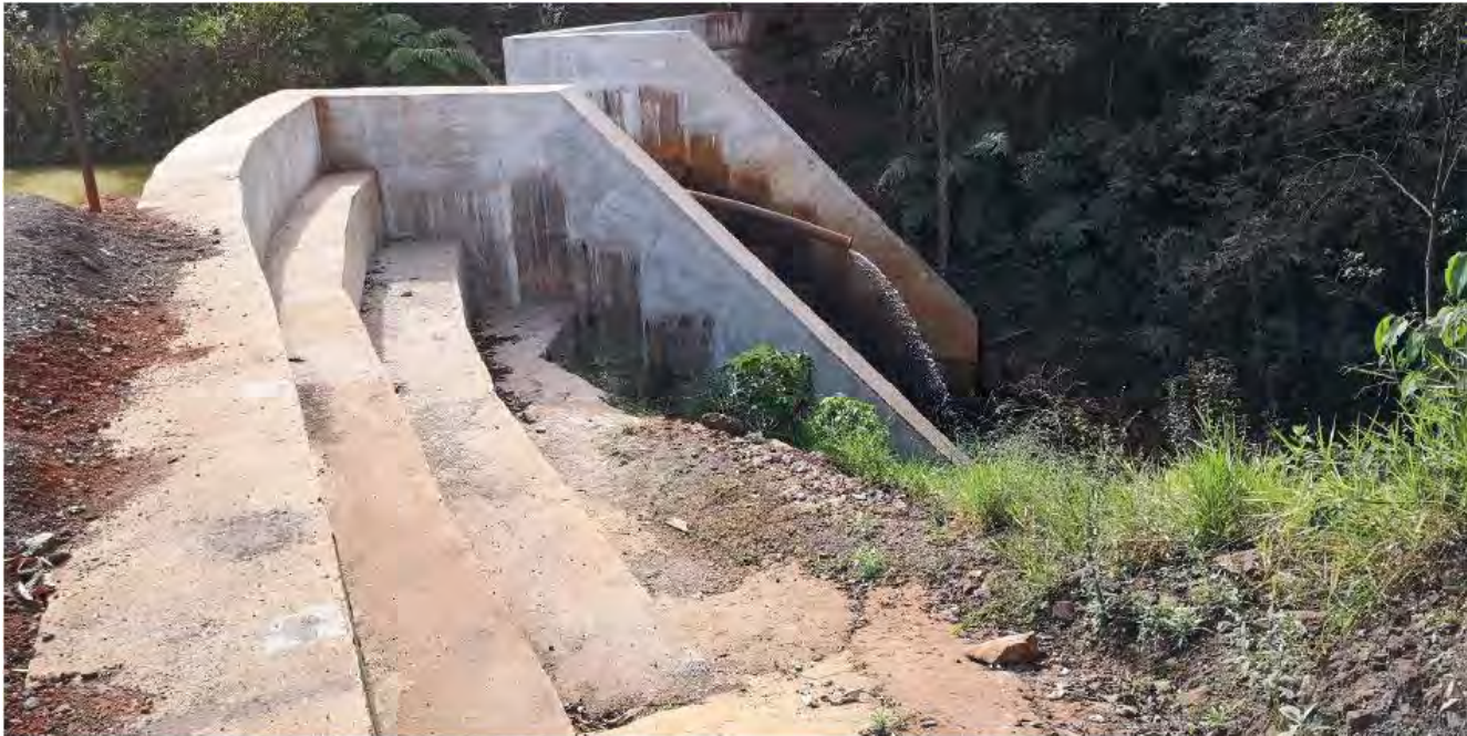
Figura 4 - Vista da parede lateral (Fonte: G103000-O-1RT009).
