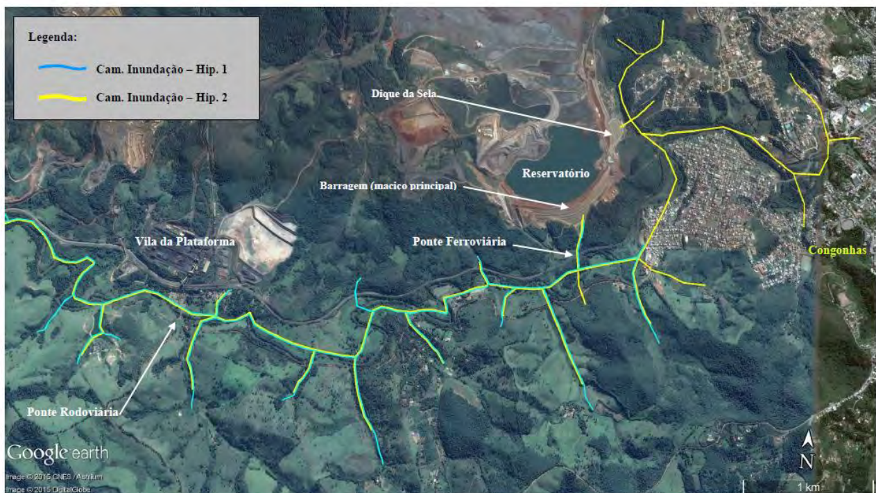
Figura 6.3 – Caminho de Inundação – Trecho de 0 a 4,7 km a jusante do dique da sela e de 0 a 6,9 km a jusante do maciço principal
