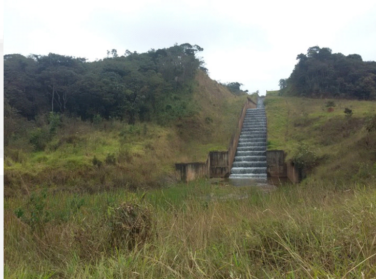
Figura 10. Canal extravasor. Vista da descida em degraus.
