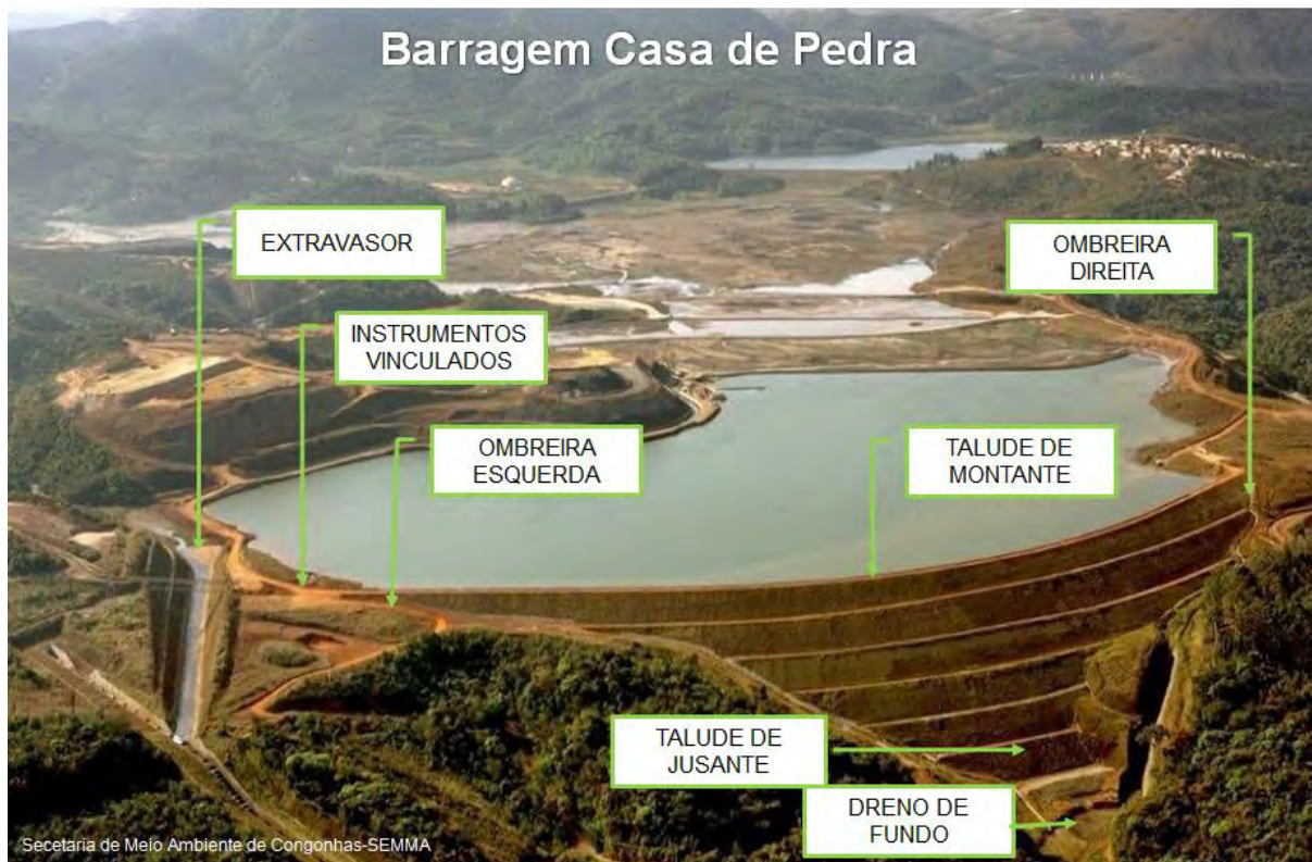
Figura 5: Nomenclatura das estruturas de barragens.
