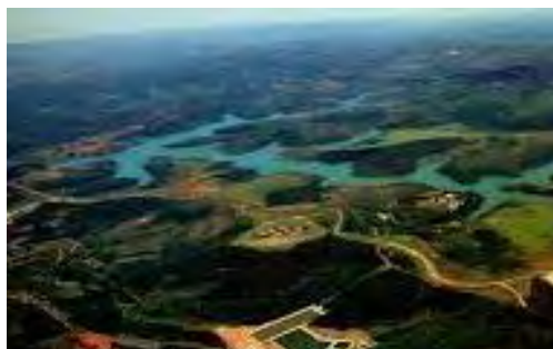
Figura 22: Barragem do Lago Soledade.
