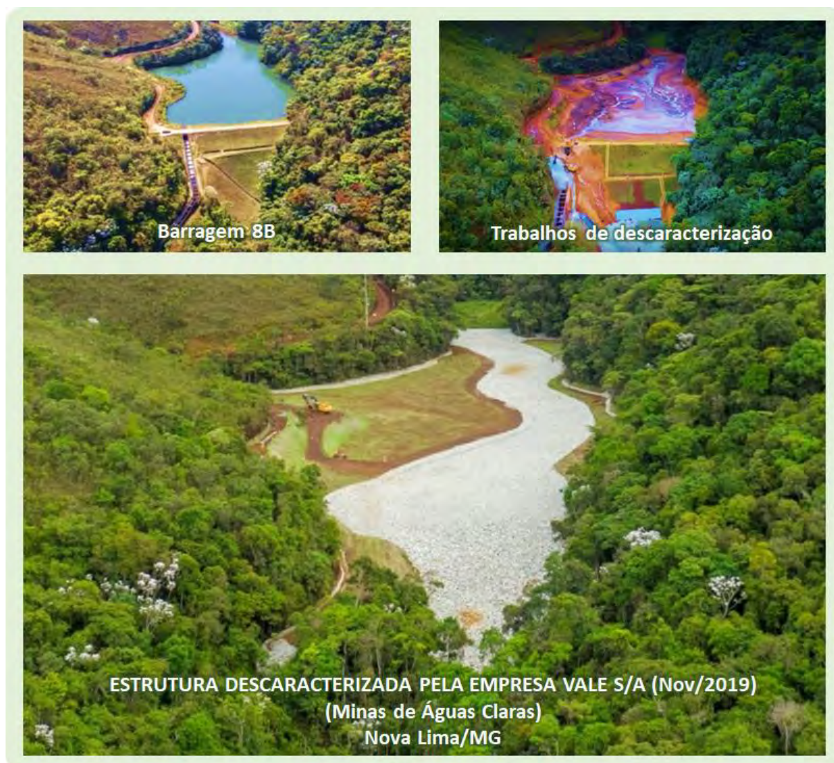
Figura 11: Etapas do processo de descaracterização realizado pela Vale na Barragem 8B.
