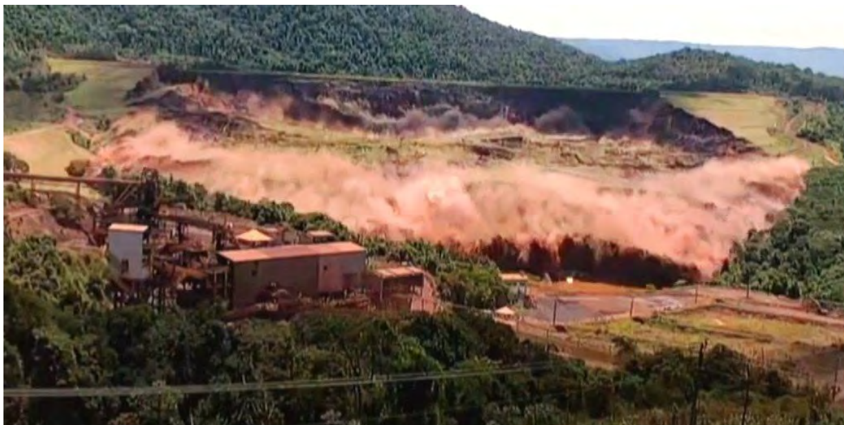
Figura 19: Rompimento da barragem B1 em Brumadinho em Janeiro de 2019.
