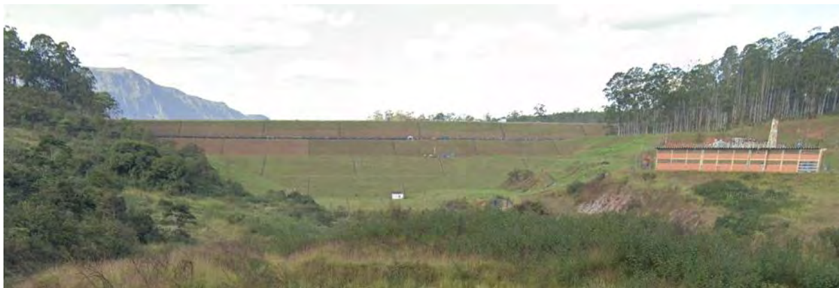
Figura 13: Barragem Lago Soledade (Vista Lateral).
