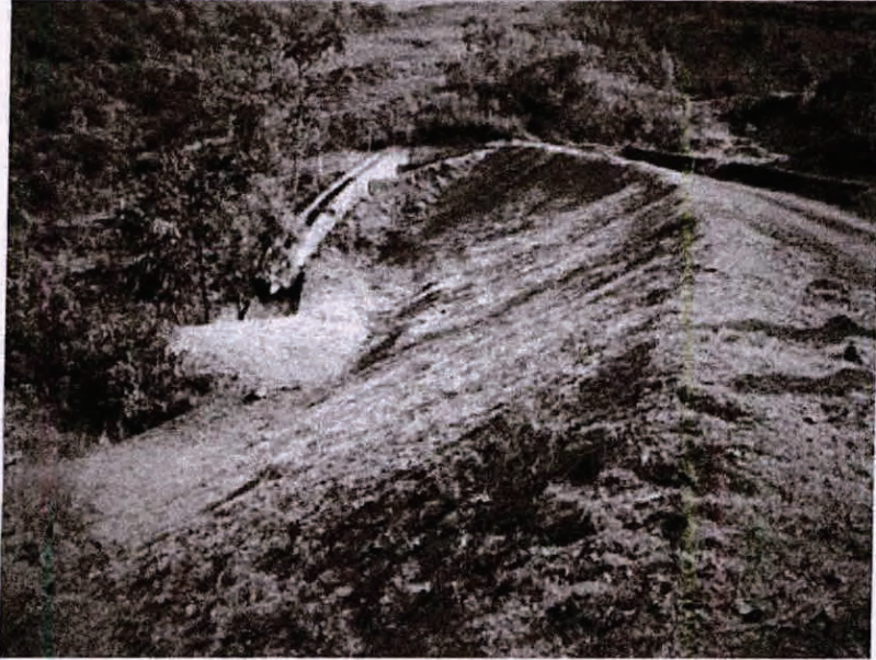
Foto 3: Talude de jusante.
