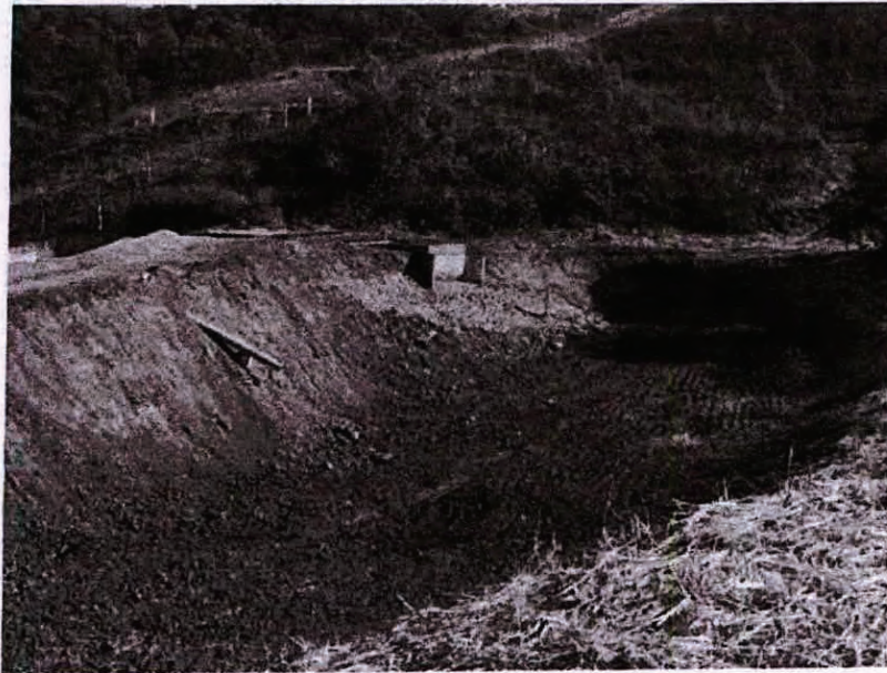
Foto 1: Reservatório, talude de montante e vertedor.
