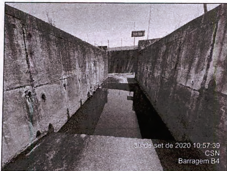
Foto 43 – Bacia de dissipação do sistema extravasador.
