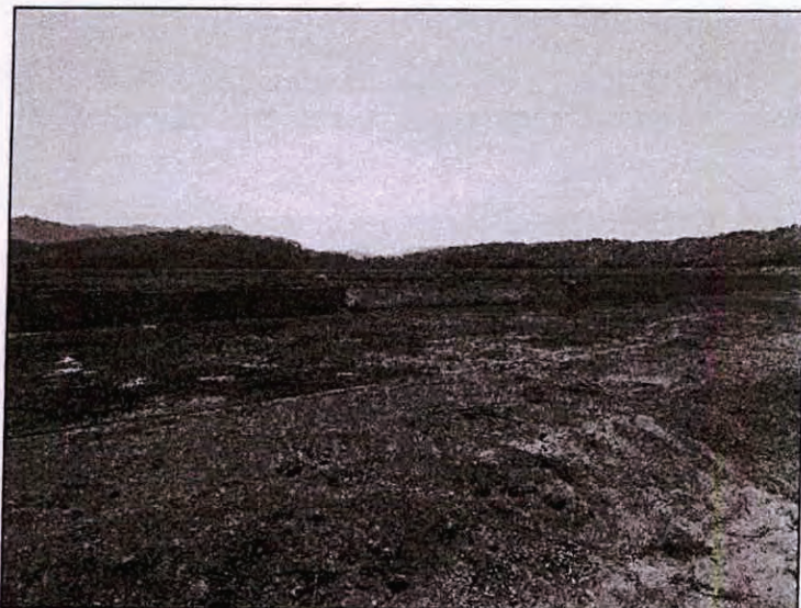
Foto 27 – Vista do reservatório a partir da crista.
