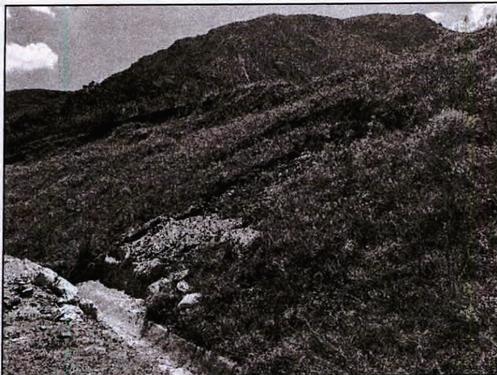
Foto 65 – Vista do escorregamento mais a montante. Detalhe para a preparação do local para tratamento do pé do talude com sacos de solo/cimento.
