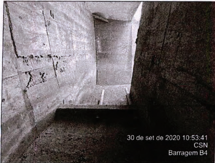
Foto 40 – Vista do desemboque da galeria sob o maciço da barragem.
