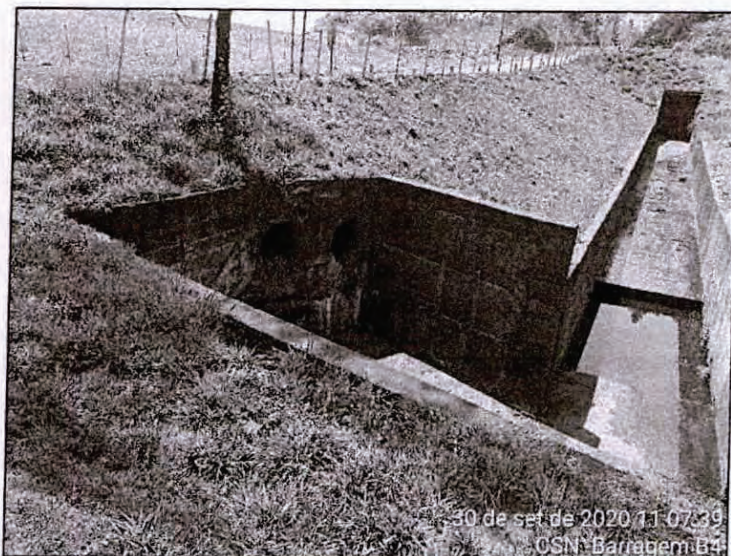
Foto 46 – Vista do desemboque da drenagem superficial, no canal extravasador.
