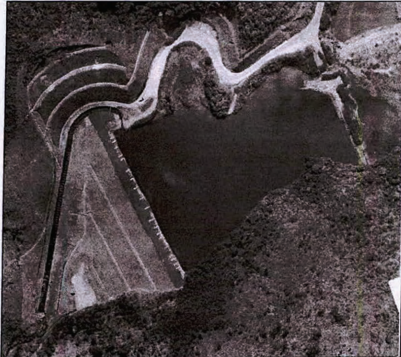
Figura 56 – Vista do reservatório e do talude montante do Dique do Esmeril IV.
