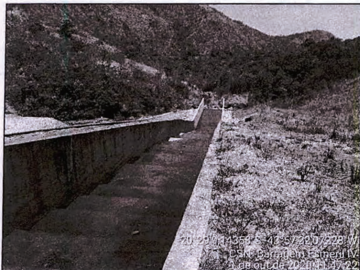
Foto 71 – Canal extravasor com degraus e vista da bacia de dissipação.
