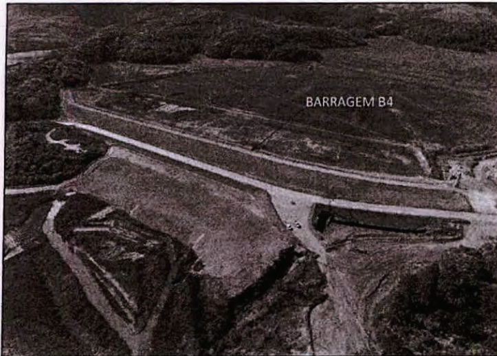
Figura 46 – Vista frontal da Barragem B4.
