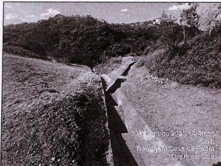
Foto 26 – Ponto de redirecionamento da descida d'água na ombreira direita do dique de sela.
