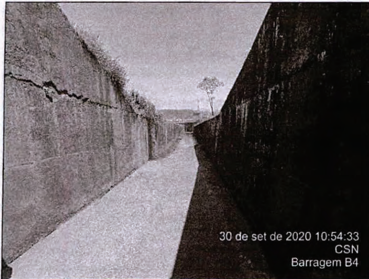
Foto 41 – Canal extravasor a jusante da galeria sob o maciço da barragem.
