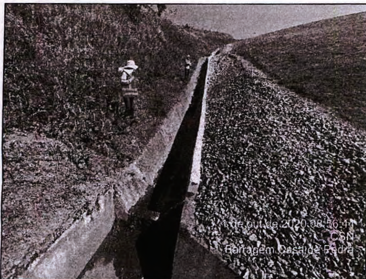
Foto 23 – Vista da descida d'água, na ombreira direita do maciço, onde observaram-se algumas surgências.
