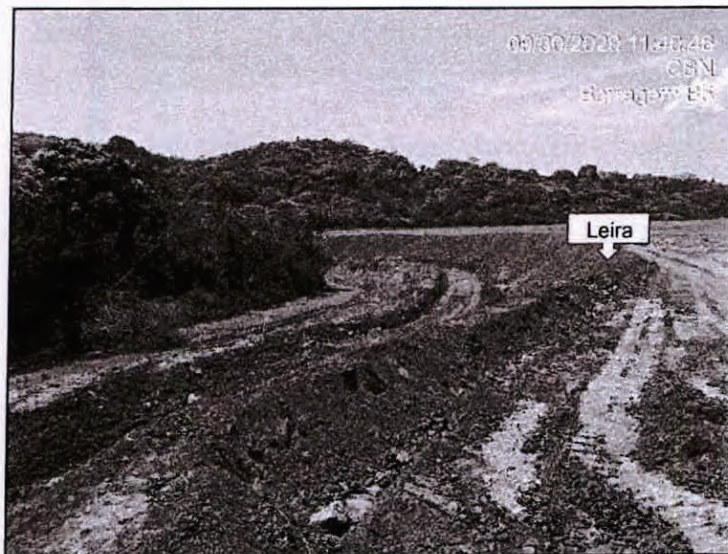
Foto 50 – Vista de leira contornando o reservatório (sem proteção vegetal), cuja drenagem é conduzida para o acesso e para o canal de cintura, na margem esquerda.
