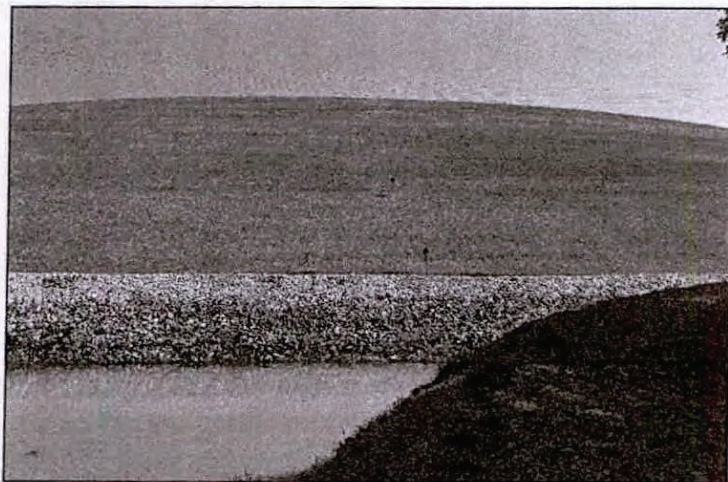
Foto 5 – Vista frontal dos taludes de jusante da barragem.
