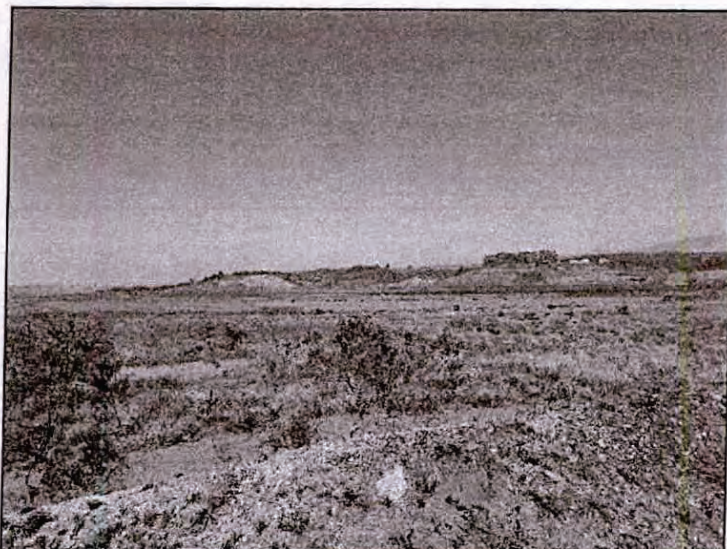
Foto 1 – Vista do reservatório da barragem de Casa de Pedra a partir da ombreira esquerda.
