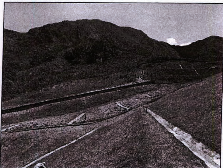
Foto 62 – Vista do encosto da estrutura com a ombreira direita.
