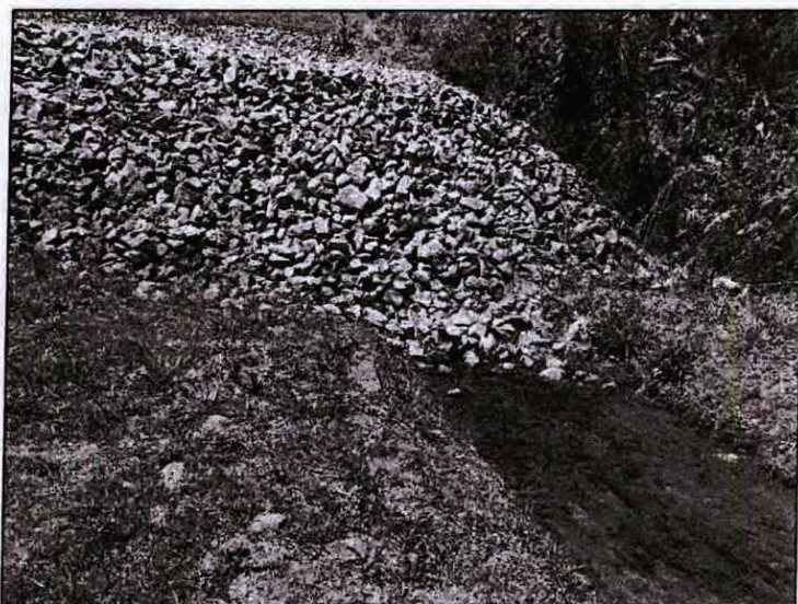
Foto 68 – Vista da saída do dreno de fundo.
