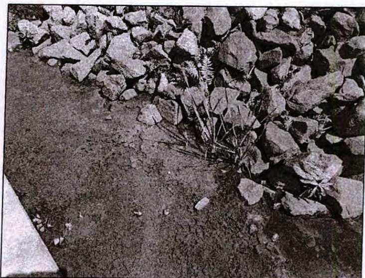
Foto 38 – Presença de colóides na saída do dreno de fundo MV-B4-01.
