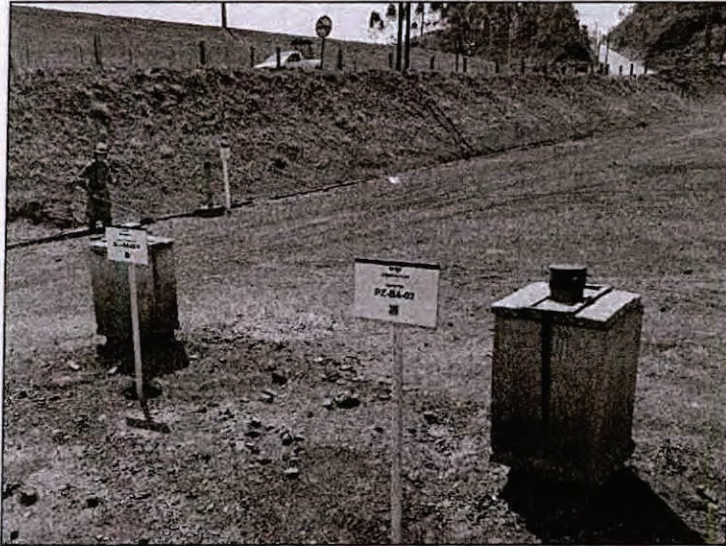
Foto 33 – Detalhe da instrumentação presente na estrutura.
