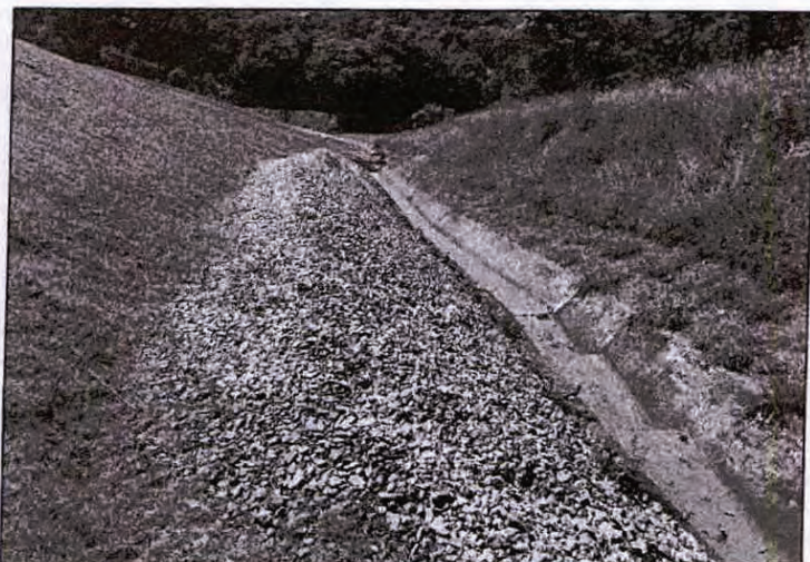
Foto 6 – Detalhe para a presença de transição com brita entre o maciço e as canaletas de drenagem superficial.
