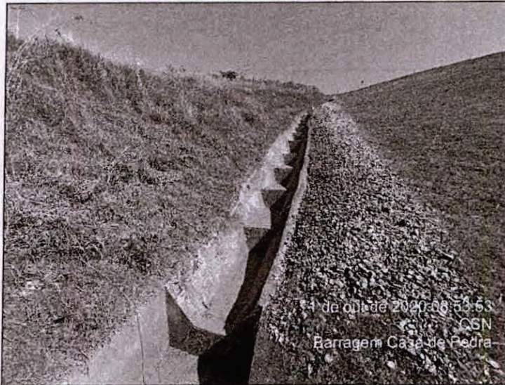
Foto 21 – Descida d'água na ombreira direita. Barragem Casa de Pedra.
