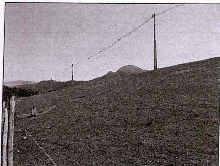
Foto 31 – Vista do talude de jusante localizado acima da estrada municipal
