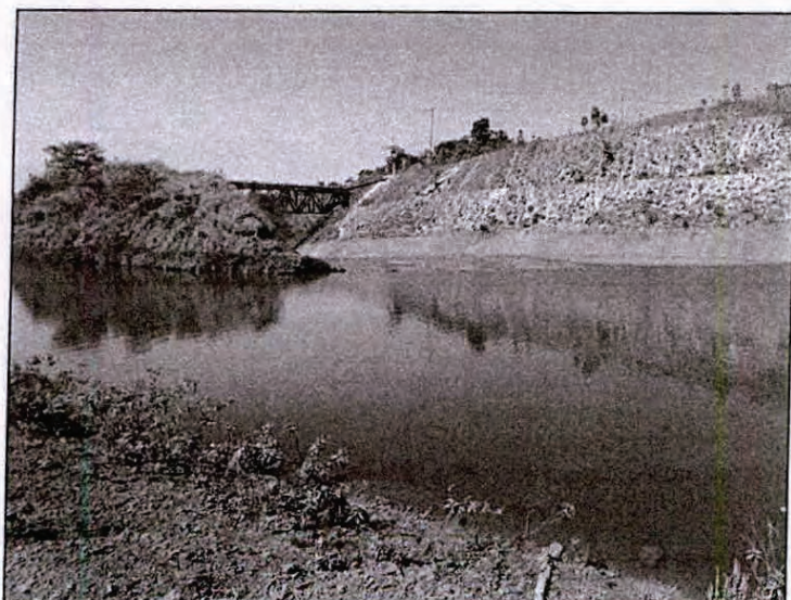
Foto 16 – Vista do emboque do canal emissário, no lago formado na margem direita do reservatório.
