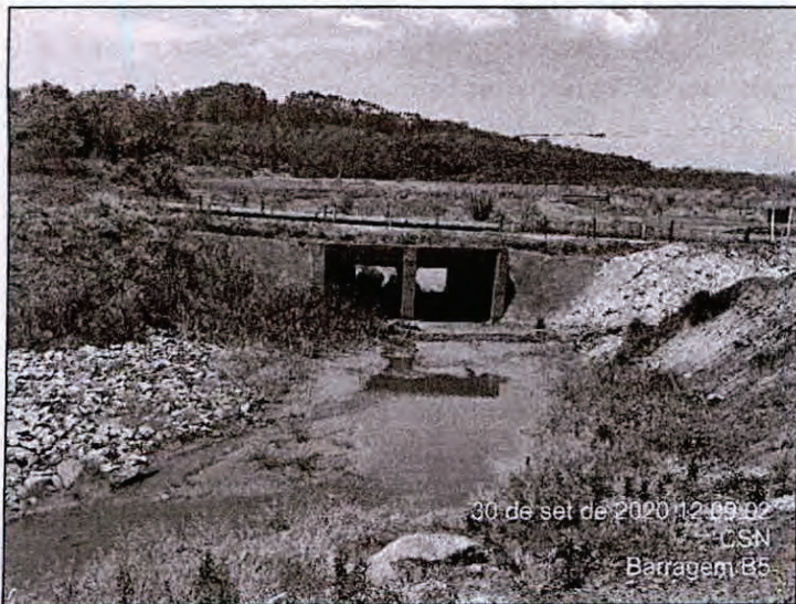
Foto 49 – Vista do emboque das galerias que conduzem o fluxo do canal de cintura e da canaleta em pedra argamassada próximo à crista. Observar sedimentos depositados na calha e vegetação se formando ao longo do canal.
