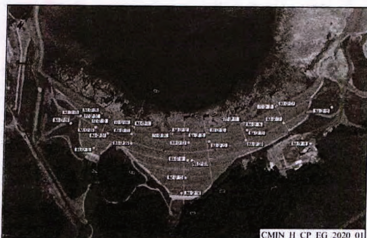
Figura 30 – Locação das seções instrumentadas no barramento principal, Casa de Pedra, e utilizadas para os estudos de estabilidade.
