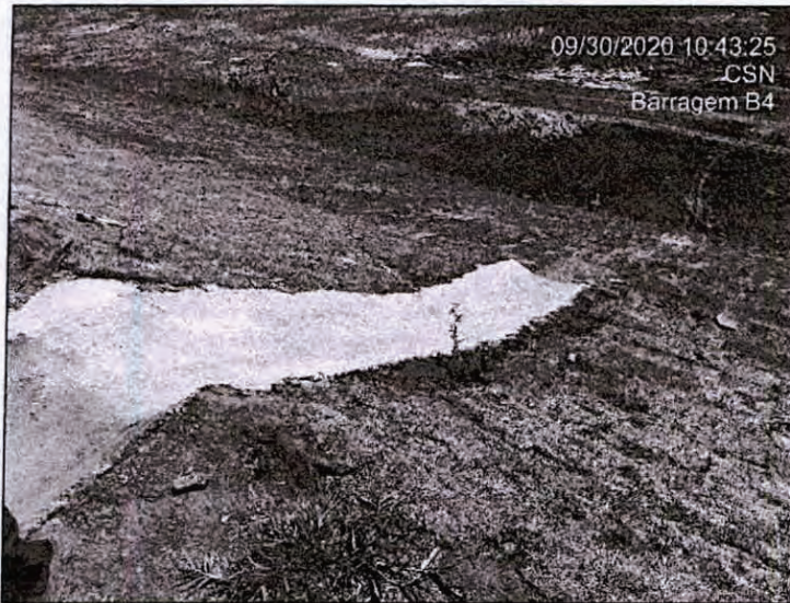
Foto 44 – Descida d'água no talude de montante.
