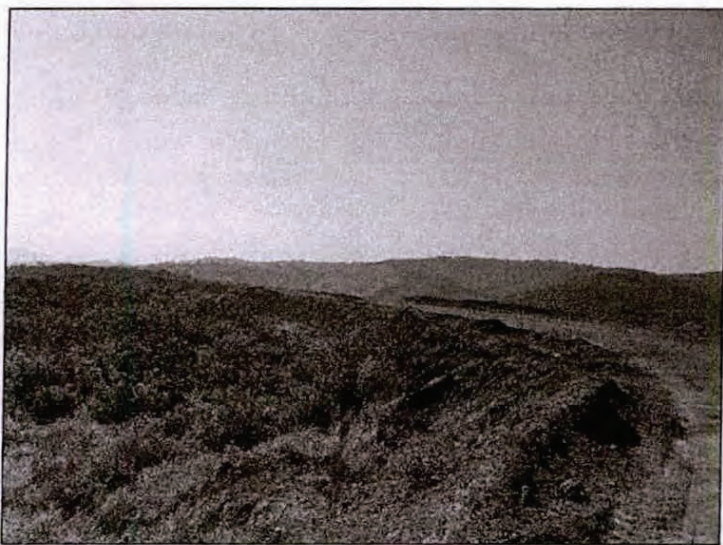
Foto 3 – Vista do talude de montante a partir da ombreira direita.
