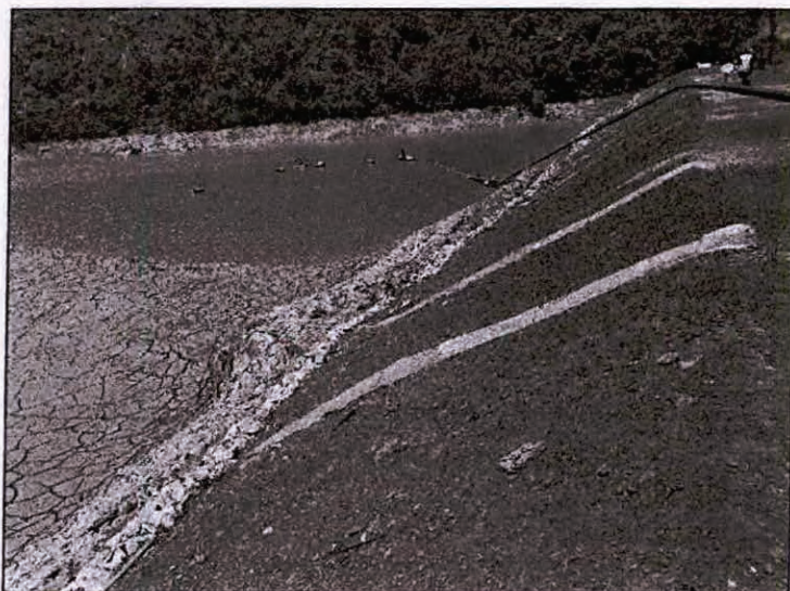
Foto 55 – Talude de montante do dique. Detalhe para a presença de canaletas de drenagem e faixa de proteção de rip-rap .
