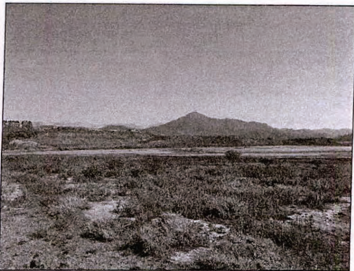
Foto 2 – Vista do reservatório da barragem de Casa de Pedra a partir da ombreira direita.
