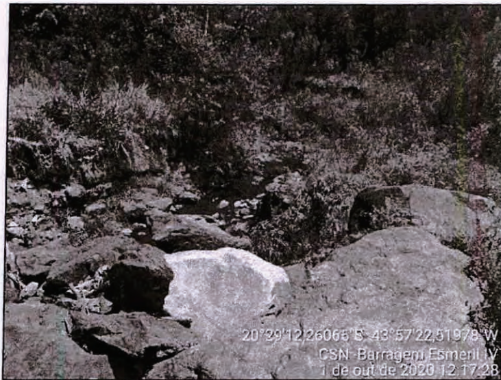
Foto 72 – Região de restituição do fluxo ao terreno natural, com blocos de enrocamento.
