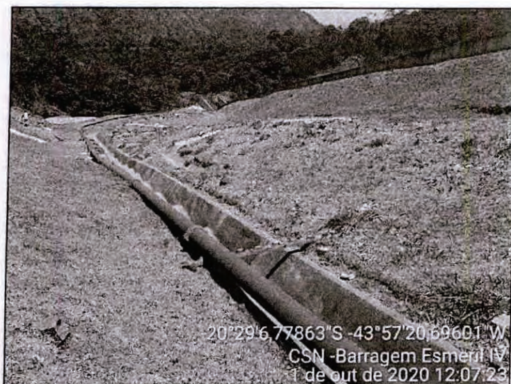
Foto 76 – Canaleta periférica, com degraus, na ombreira direita.
