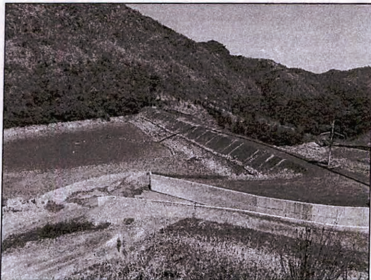
Foto 54 – Vista do reservatório e talude de montante a partir da ombreira direita.
