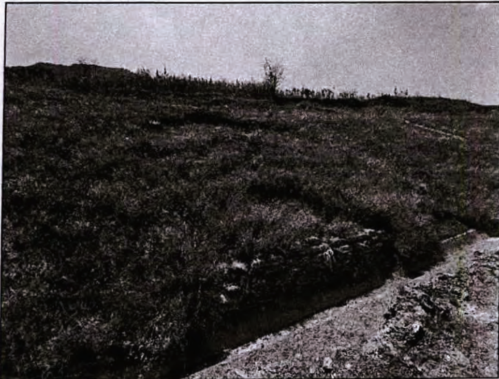
Foto 64 – Vista do escorregamento mais a jusante. Detalhe para o tratamento executado no pé do talude com sacos de solo/cimento.
